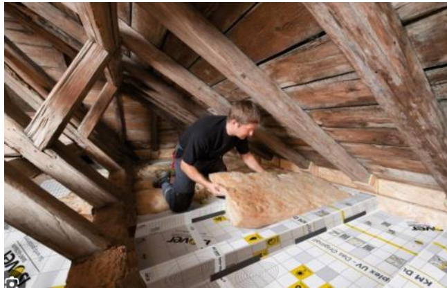
Dämmung oberste Geschossdecke
