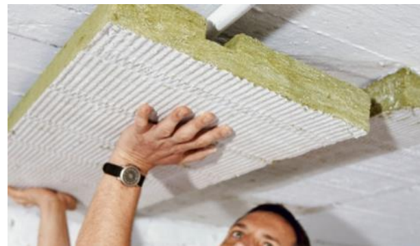
Dämmung Kellerdecke
